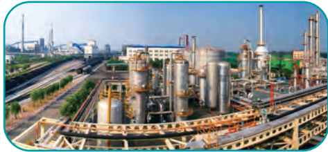
3 Dingzhou, Hebei 河北定州
